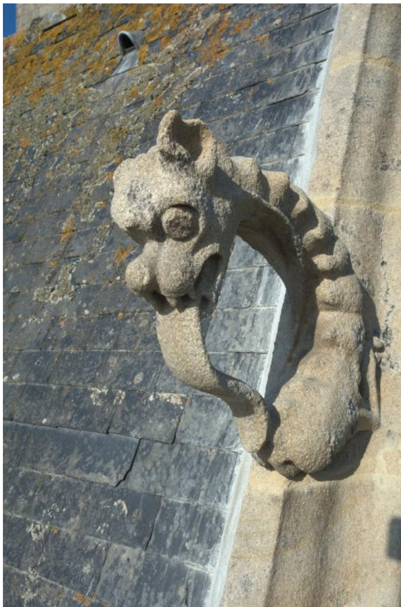
Sculpture sur rampant du pignon du porche nord
