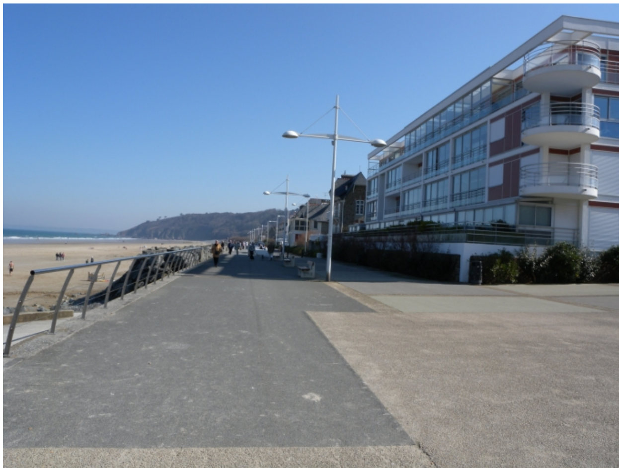
Vue des immeubles modernes sur la digue-promenade
