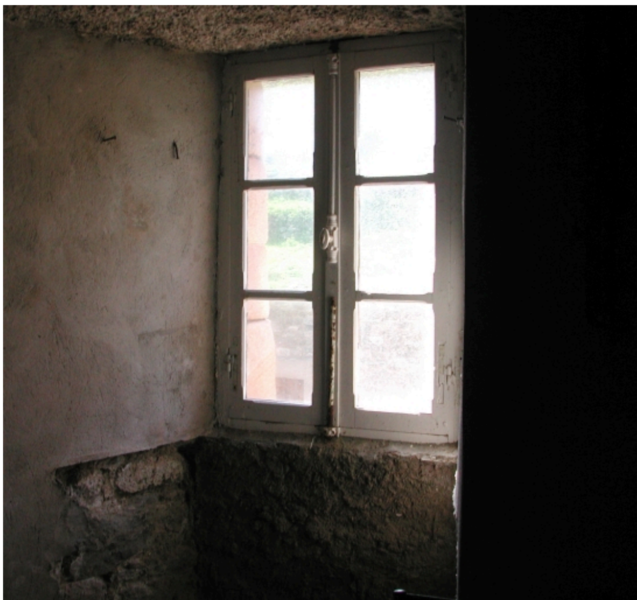
Ouverture sud du 1er étage : remarquer les enduits en ciment
