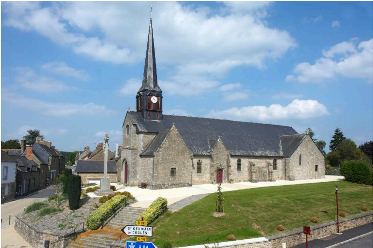
Élévation Sud : vue du sud-ouest
