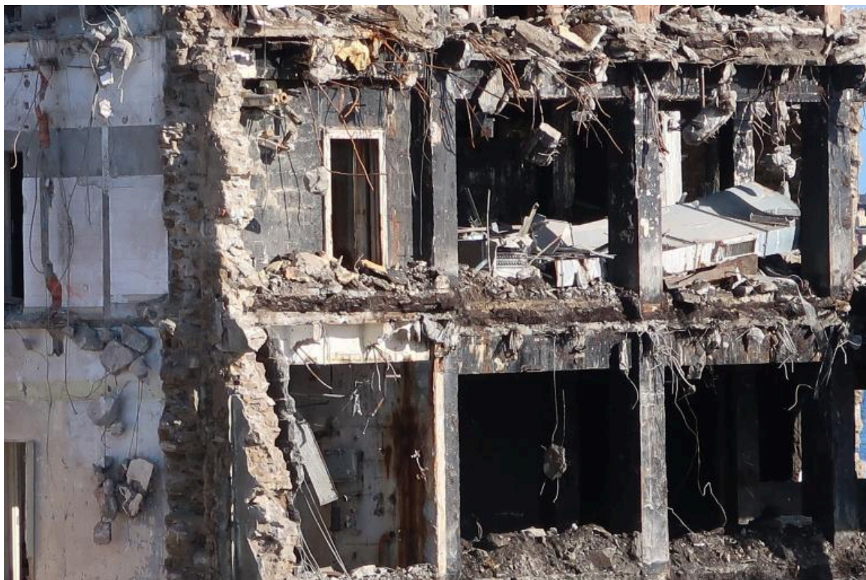
Déconstruction de l'ancien frigorifique, 10 mars 202
