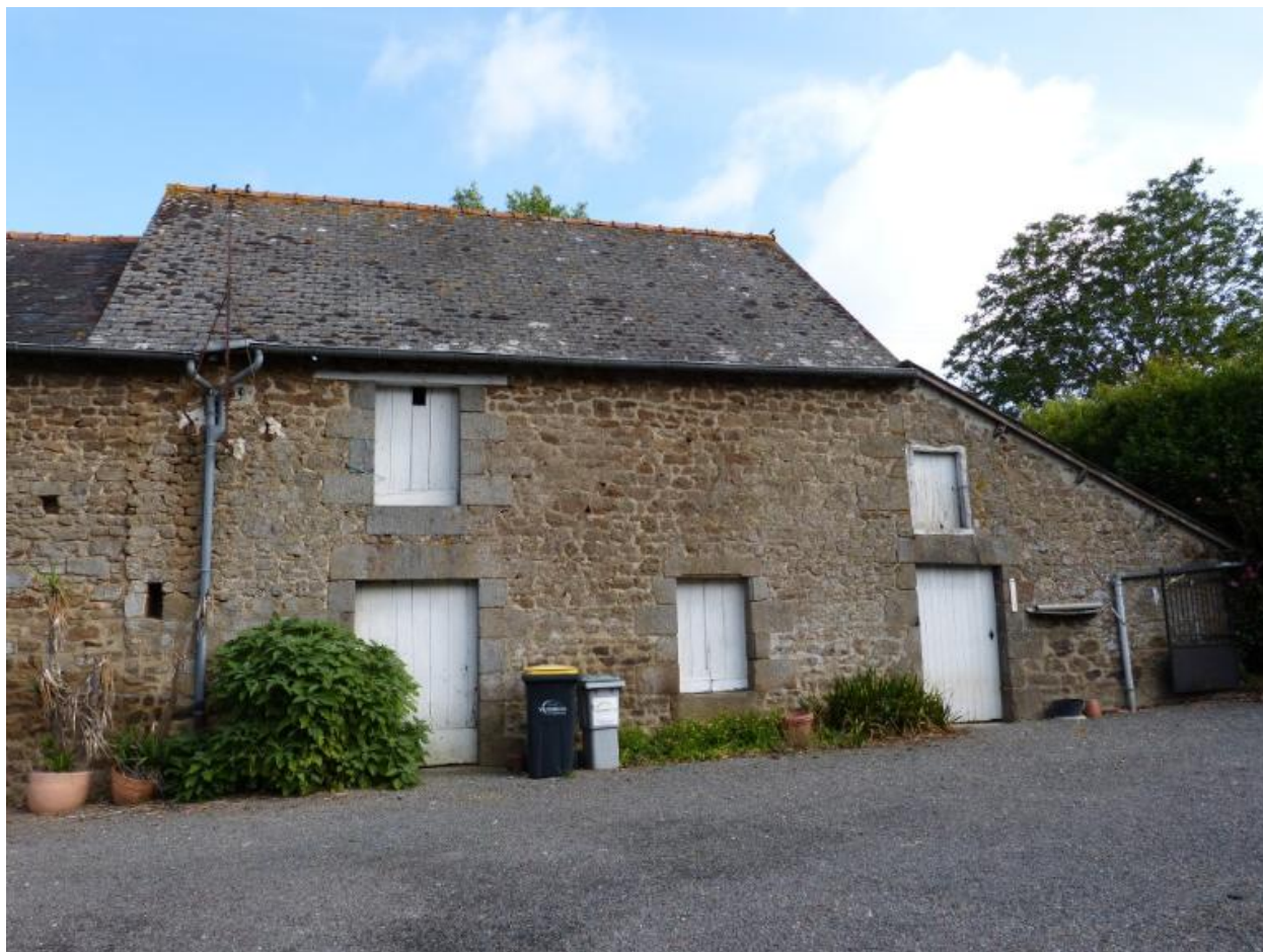
Vue générale sud
