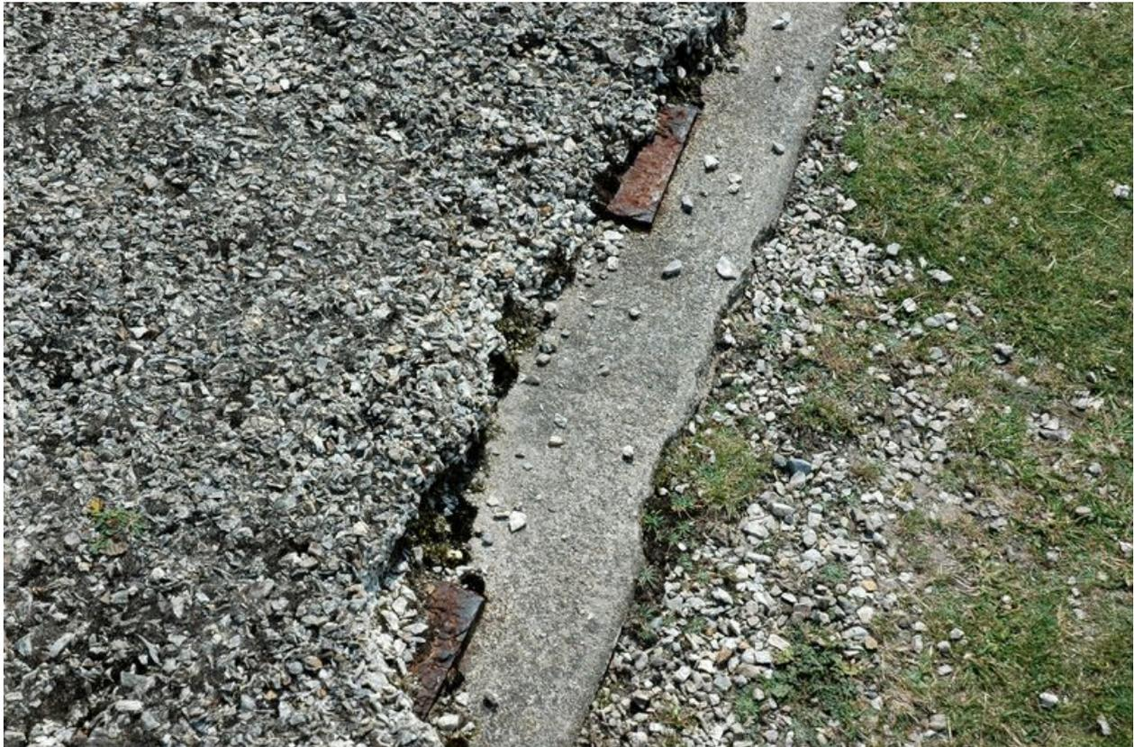
Vue de détail du ballast en béton du rail (état en 2004). Il mesure plus de 22 m de diamètre ; les fixations du rail sont visibles
