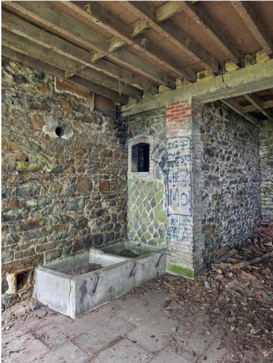
Vue de l'intérieur des communs et dépendances : double bassin en ciment armé alimenté par un tuyau et citerne maçonnée (regard entouré de brique et appareillage polygonal). A signaler : linteau en béton armé soutenant les poutres du plancher du comble
