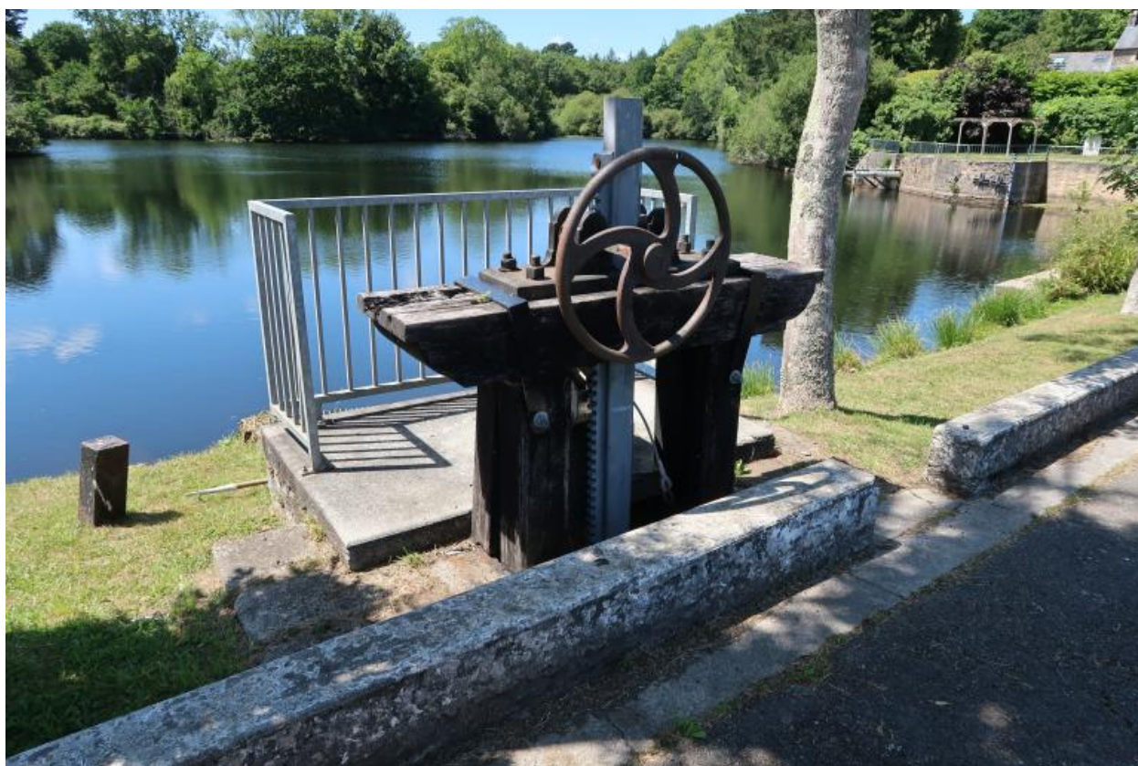
Vue de la vanne de l'étang (état en 2022)
