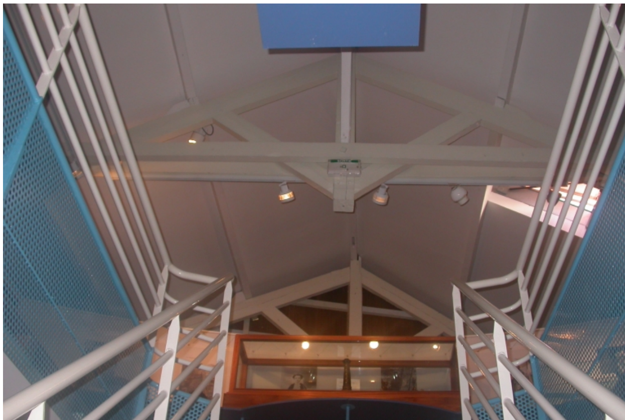
Détail de la charpente du hangar à toiles.
