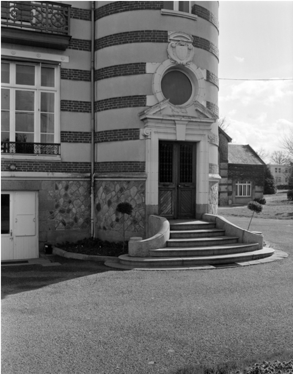
Détail de la porte d'entrée.
