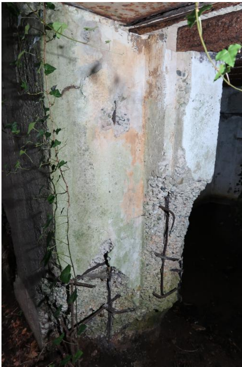
Vue de l'embrasement de la porte de la chambre de tir (état en 2021)
