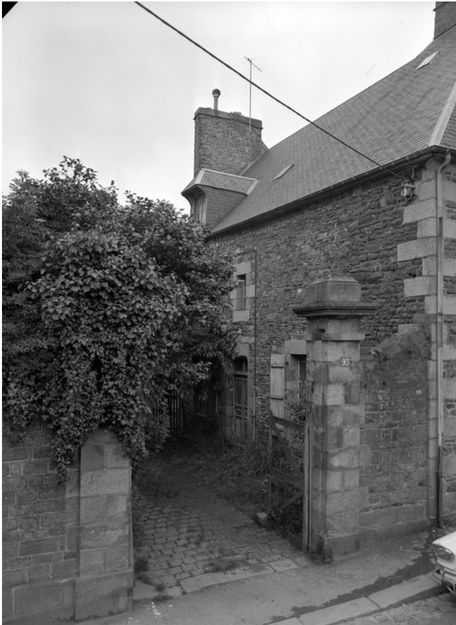
Façade sud et portail, vue générale.
