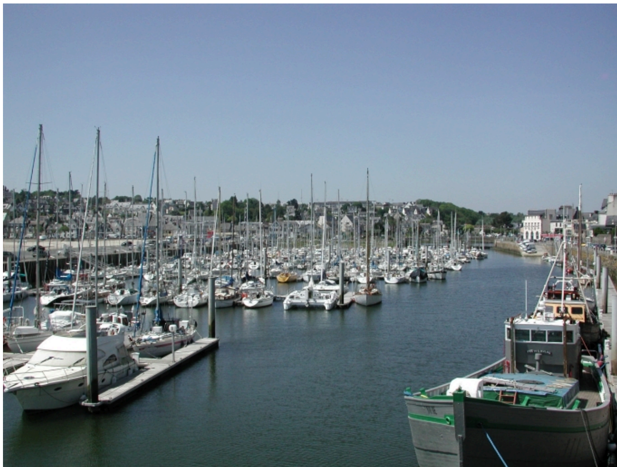
Le bassin et le ponton flottant le long du quai de Courcy
