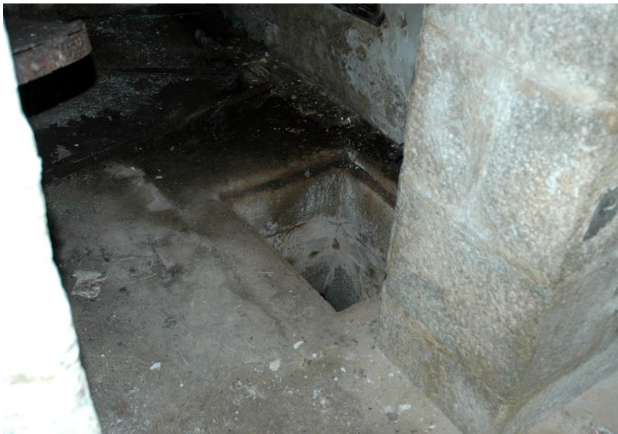
Vue intérieure : regard de la citerne (état en 2004)
