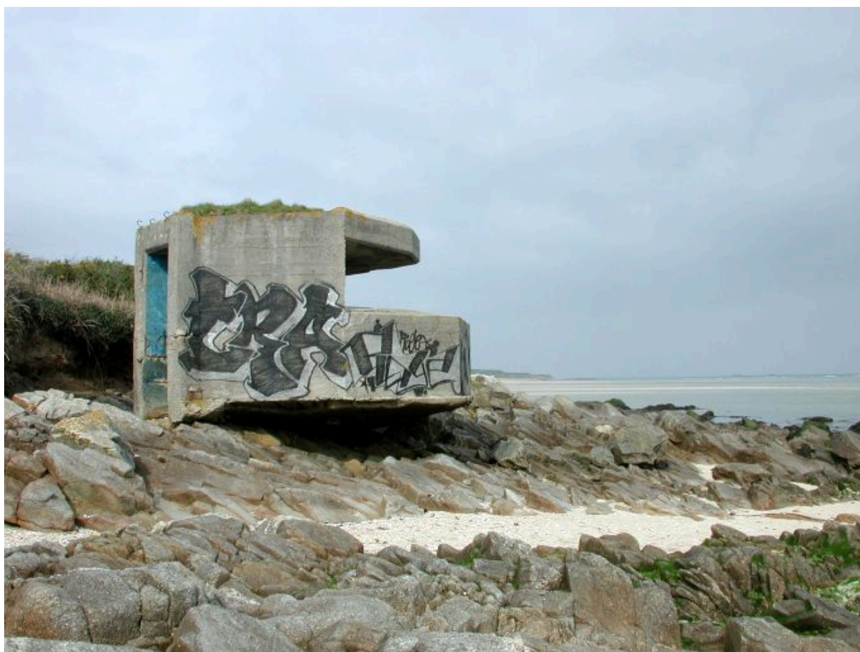
Plounéour-Trez : blockhaus de l'ensemble fortifié de Kerguelen
