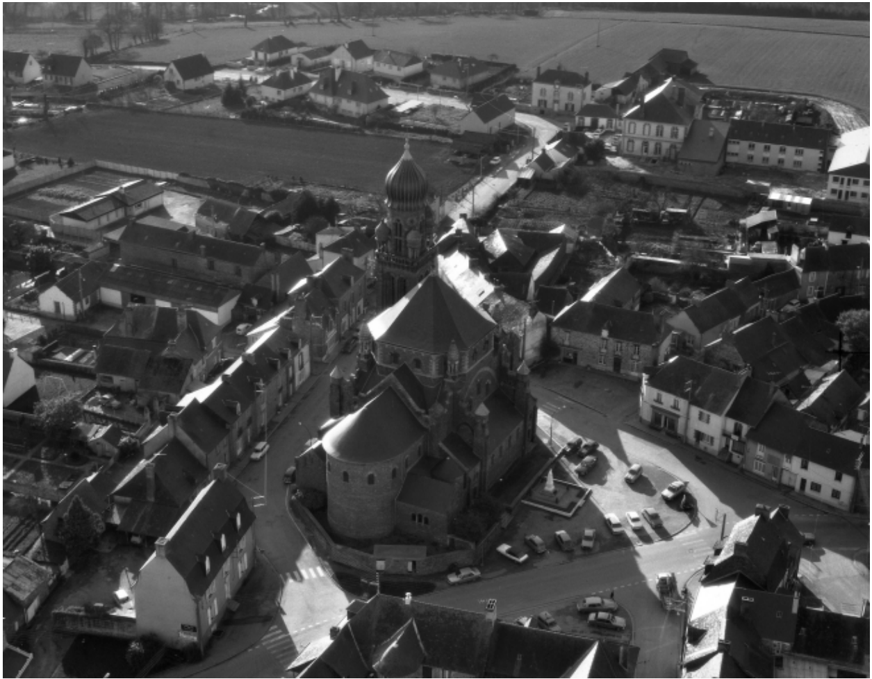
Vue aérienne, vue est.
