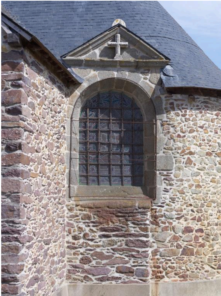
Verrière de la baie 2 : vue extérieure
