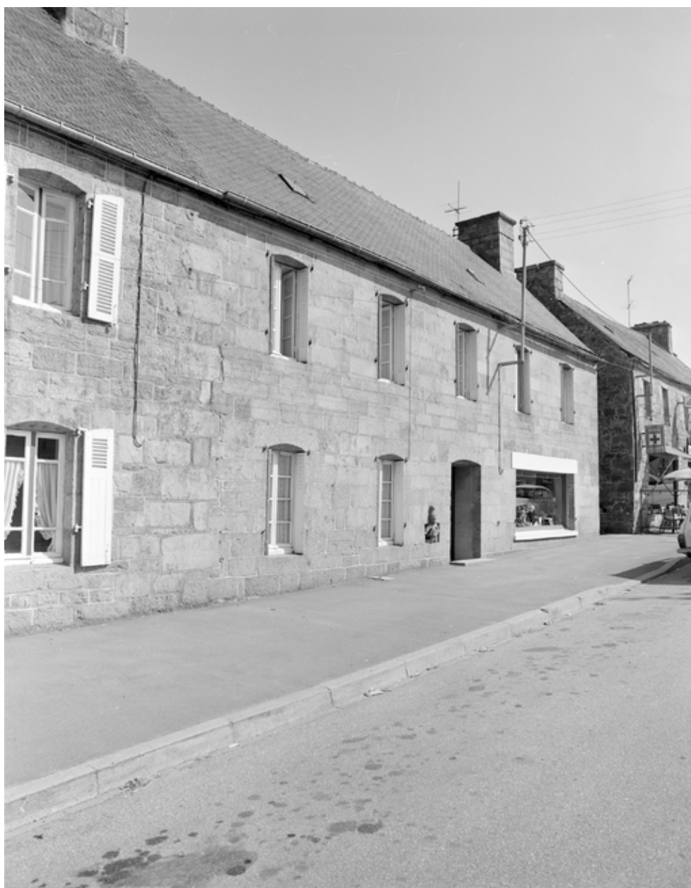
Maison 6 au bourg : vue générale sud
