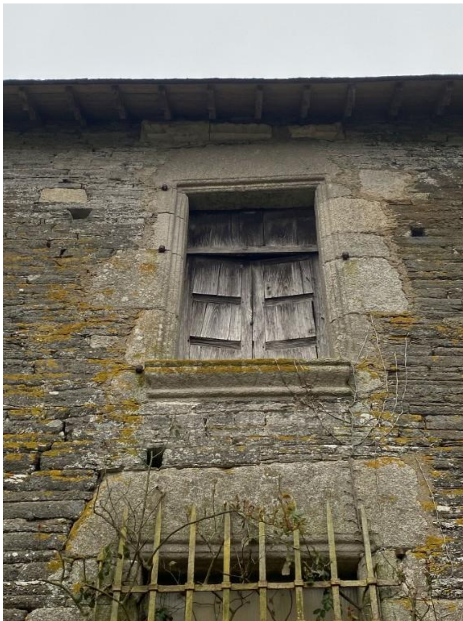
Façade ouest, détail
