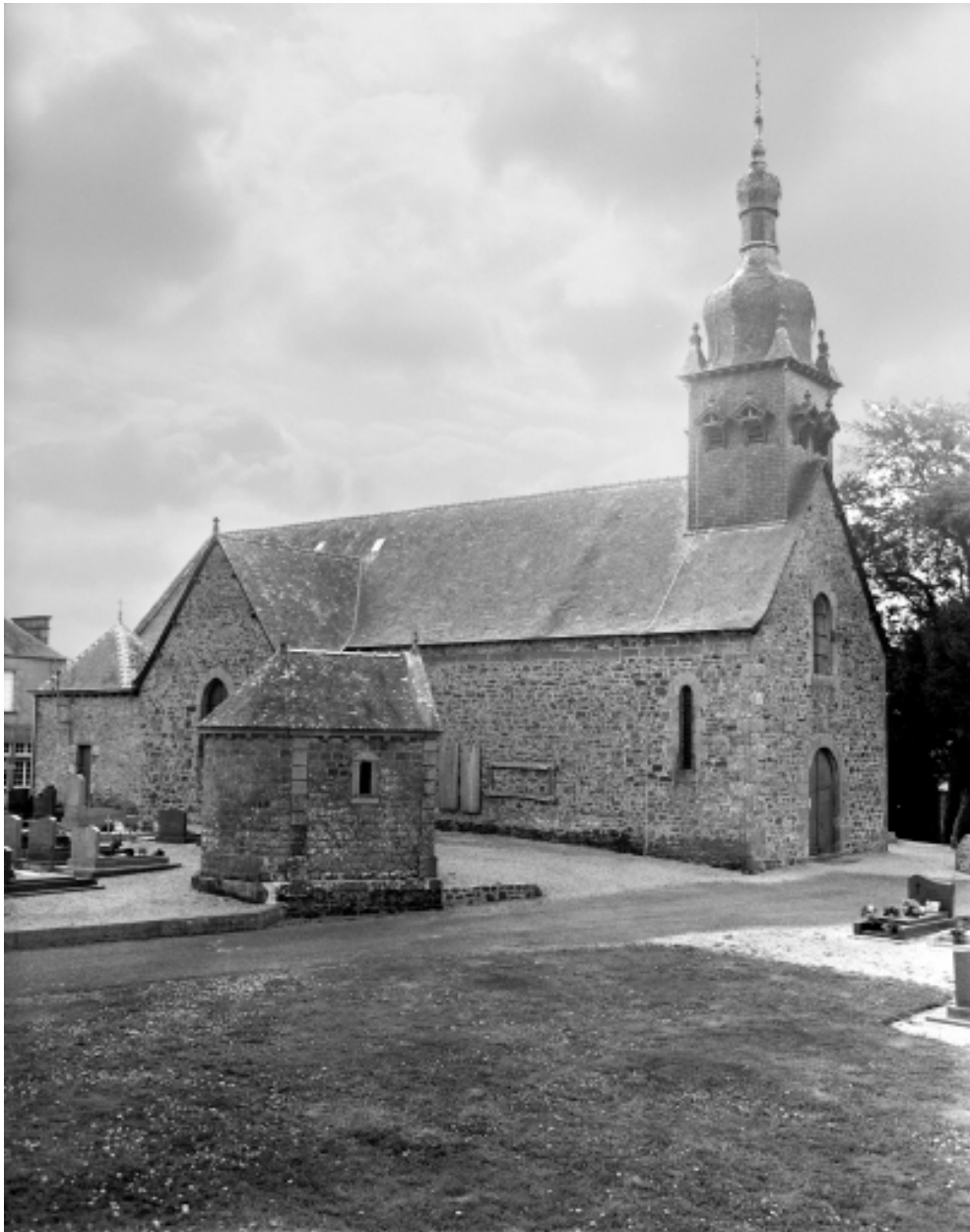
Elévation Nord-Ouest : vue générale
