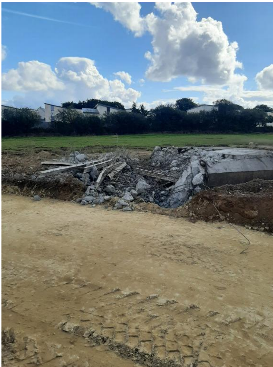
Vue de la déconstruction (25 septembre 2022)
