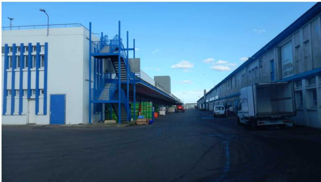
Bâtiments de la criée
