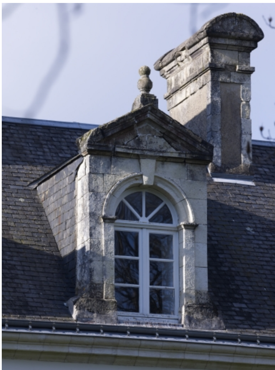
Pavillon est, élévation est : détail de la lucarne
