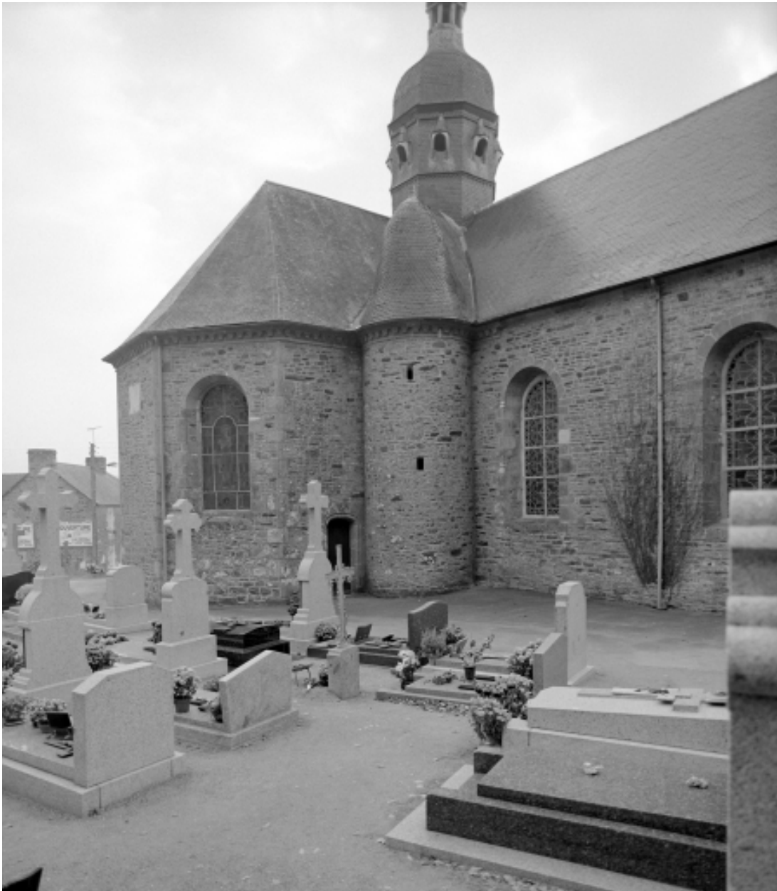
Elévation Nord, partie Est : vue générale
