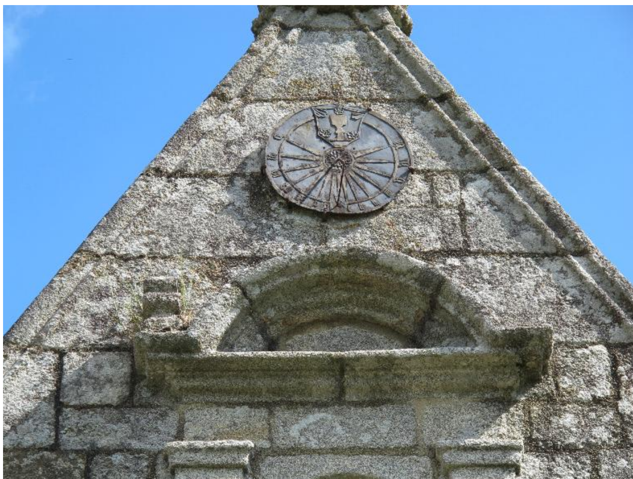
Cadran solaire, vue rapprochée
