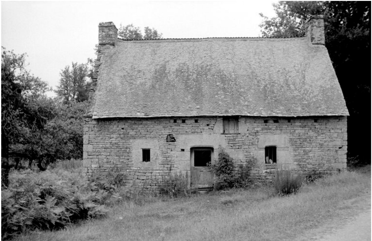
La Touche Bourdo : ferme du 16e siècle ? vue de l'ouest (état en 1969)
