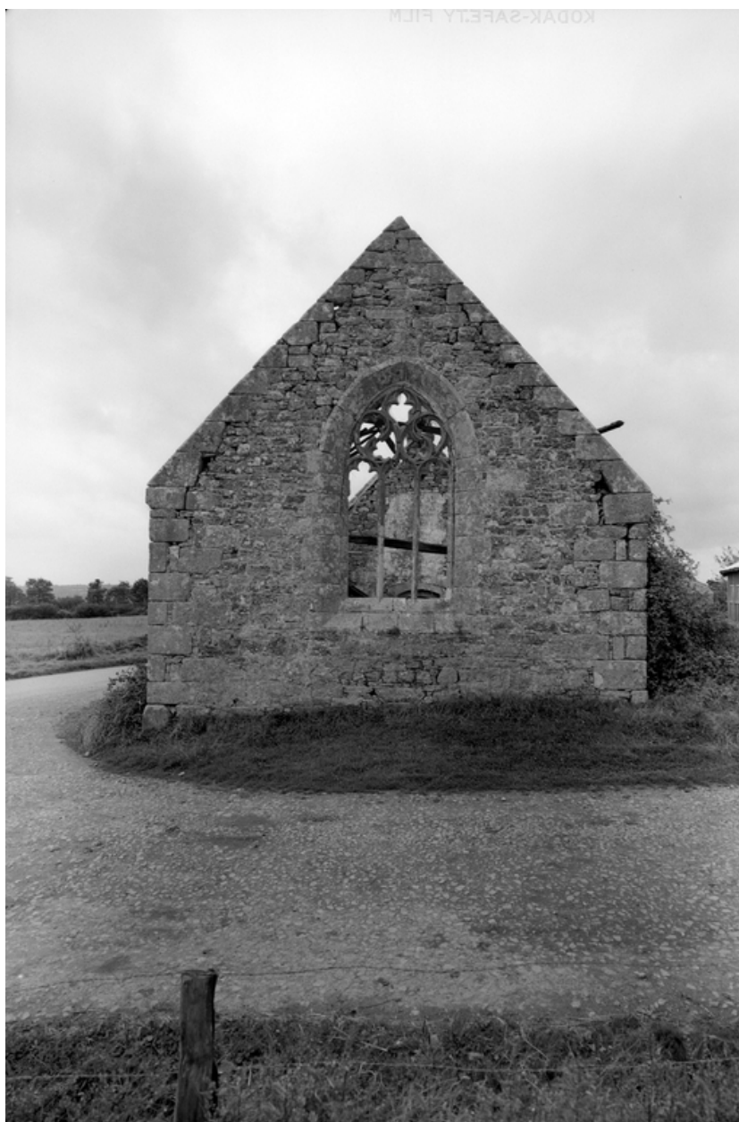
Vue générale de la face est
