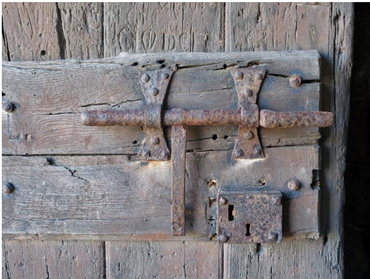
Vue de la tour Solidor : détail du dispositif de fermeture de la porte d'entrée (grand verrou et serrure). Des graffitis sont visibles sur le battant de la porte
