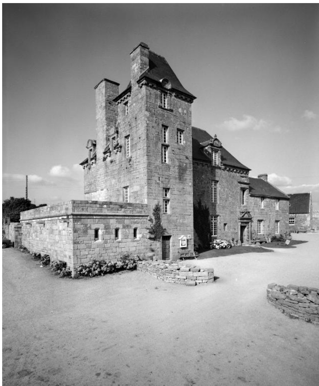
Vue d'ensemble de la façade sud, prise du sud-ouest
