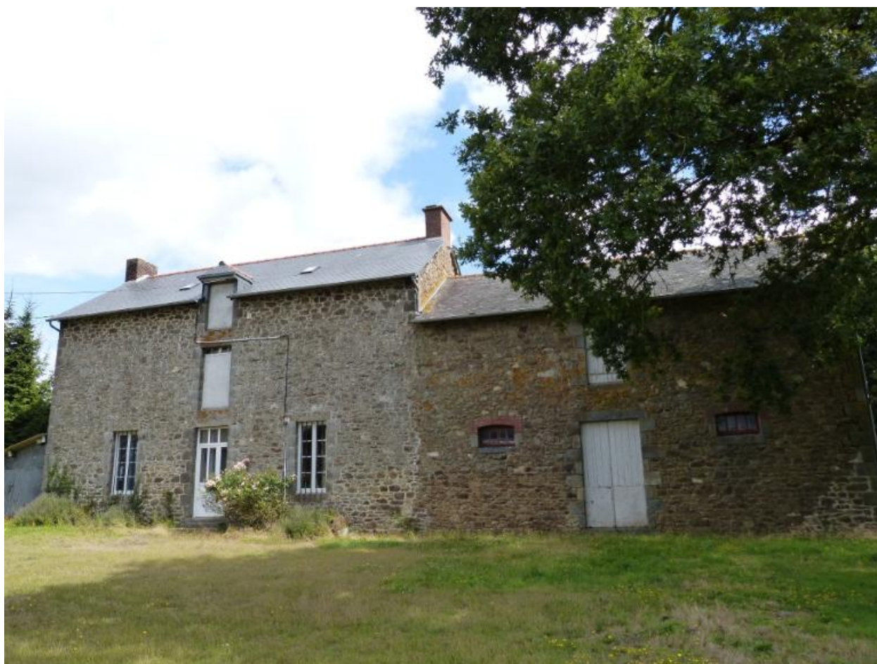
Vue générale sud
