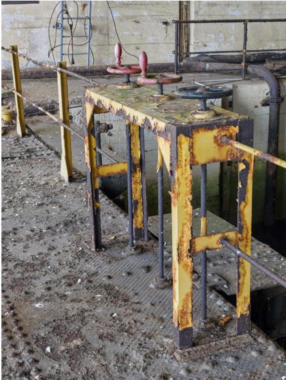
Vue des commandes des vannes du bateau-porte fermant le bassin (vers l'intérieur). On peut lire de gauche à droite : BALLAST n° 5, BALLAST n° 6, REMPLISSAGE
