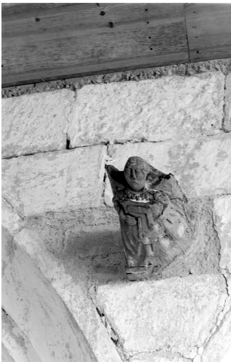
Vue de l'ange sculpté au-dessus de la 3ème pile nord de la nef
