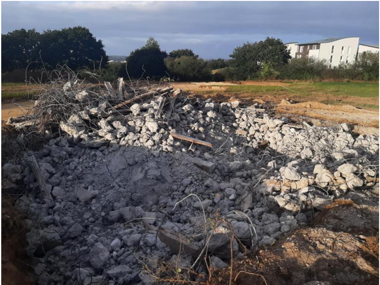
Vue de la déconstruction (26 septembre 2022)
