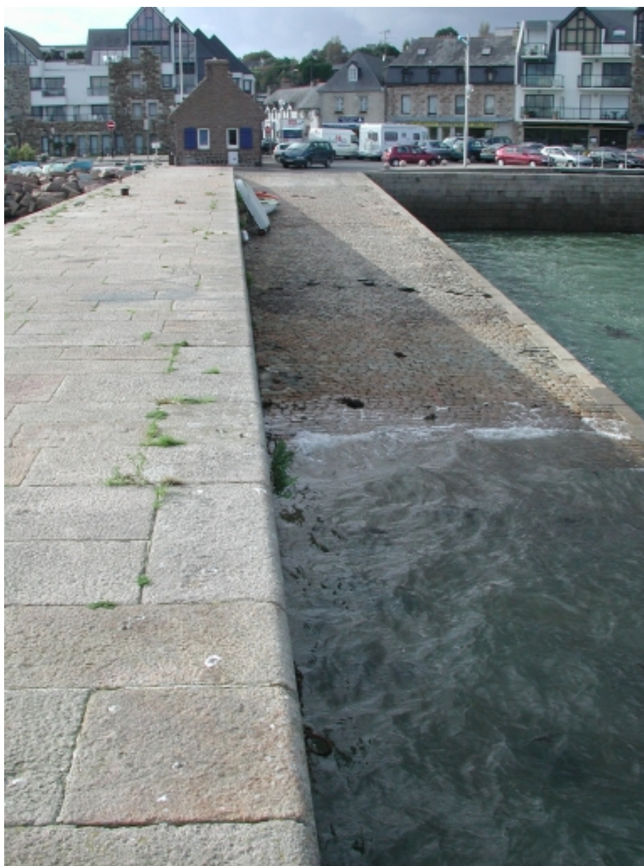
Vue de détail du revêtement des deux ouvrages : la cale Bitousse et le quai de l'Eperon en parallèle
