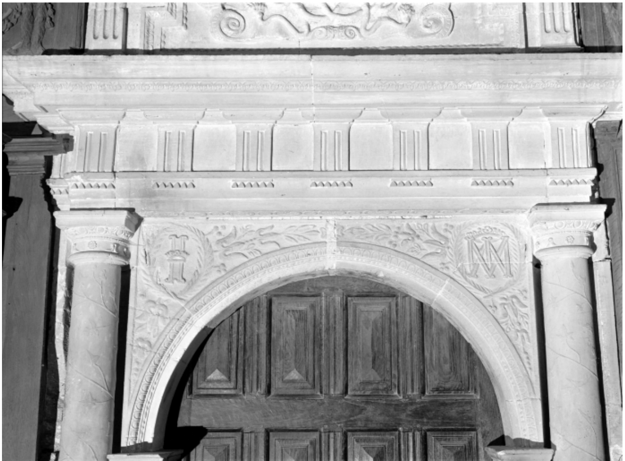
Porte sud de la sacristie, détail du premier entablement pris par dessous (frise sculptée)
