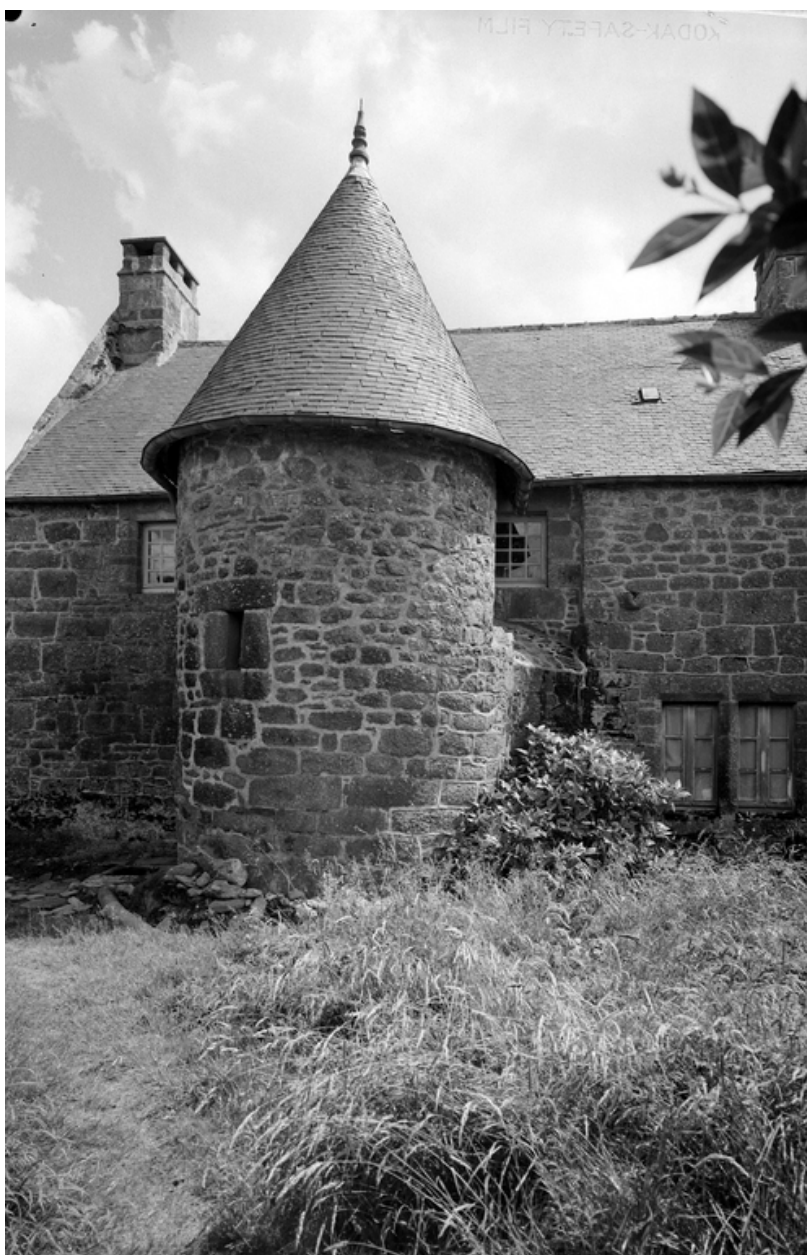
Façade nord : détail de la tourelle
