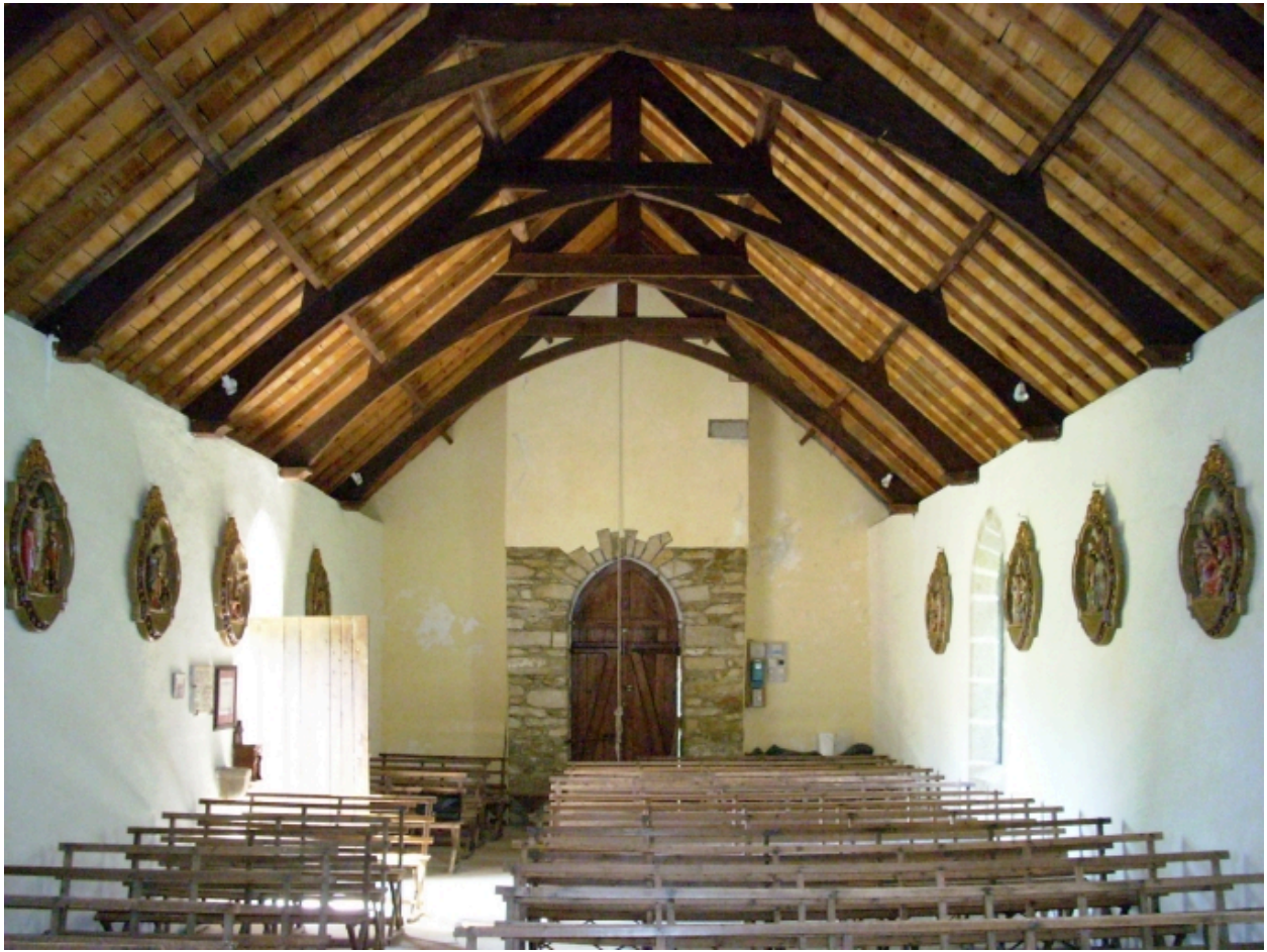
Moëlan-sur-Mer, chapelle Saint-Pierre : vue axiale ouest
