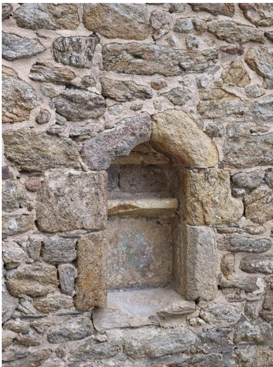
Vue de détail d'une crédence
