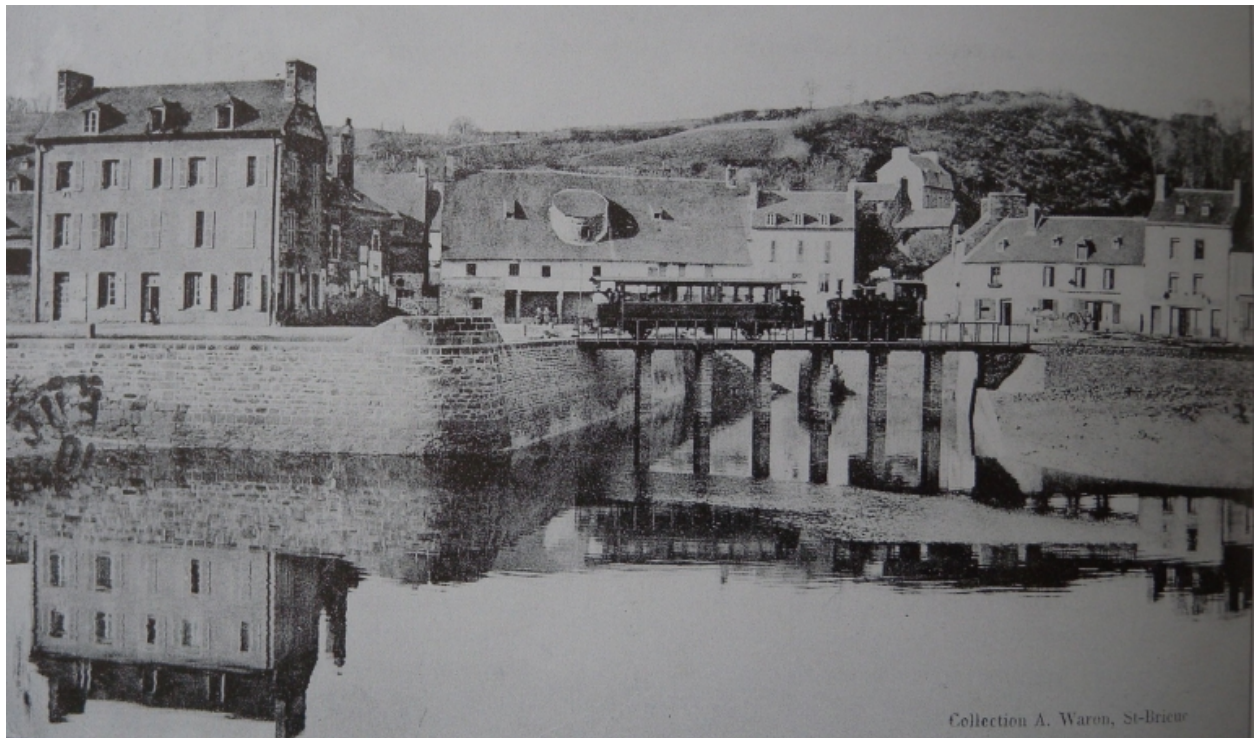
Vue de la cale de carénage rive gauche et de la passerelle pour le passage du train, début 20ème siècle (carte postale, collection particulière)
