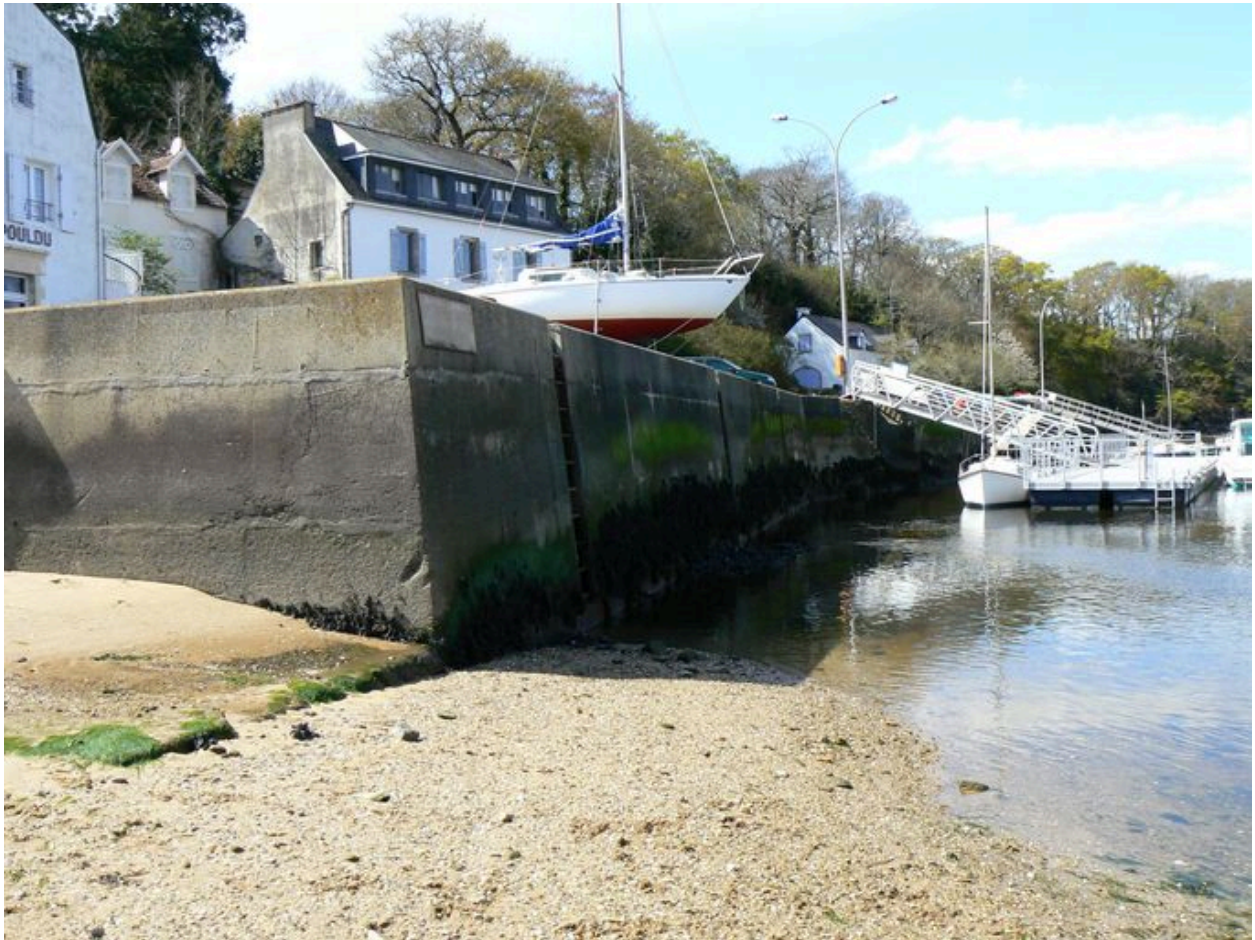
Quai en béton et extrémité inférieure de la petite cale
