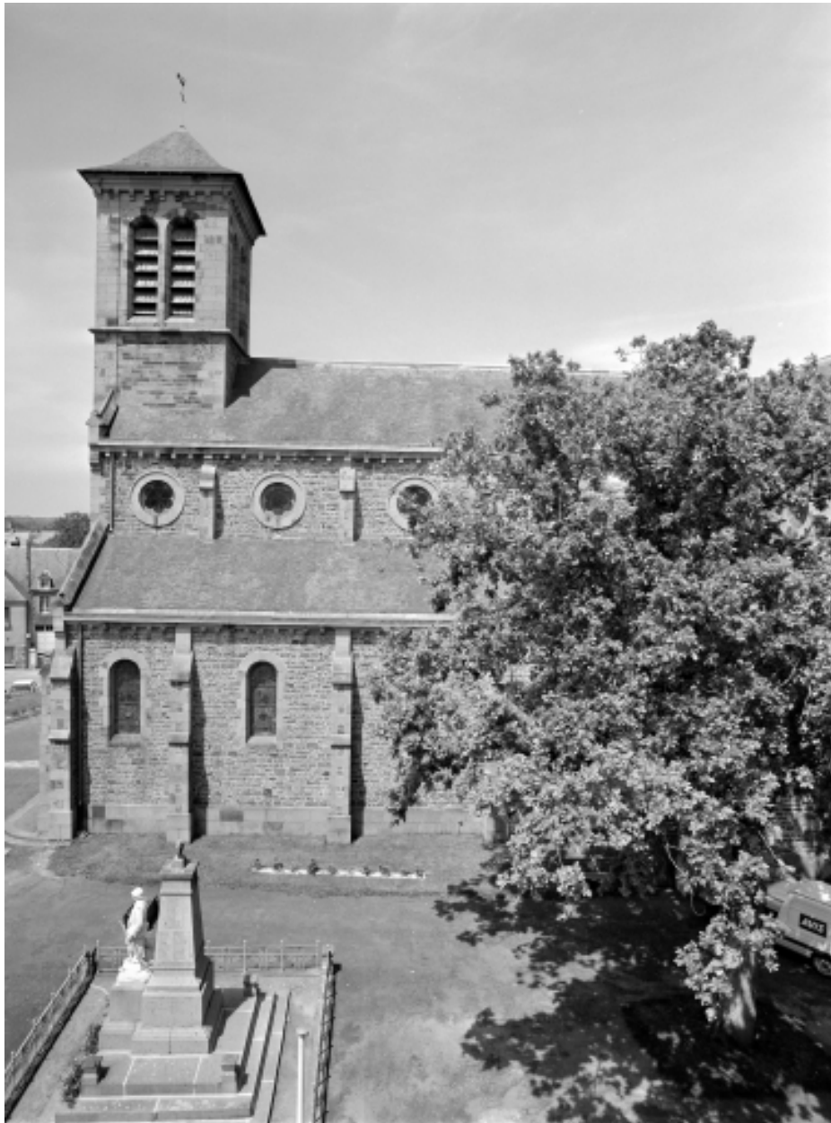
Elévation Sud, partie Ouest : vue générale
