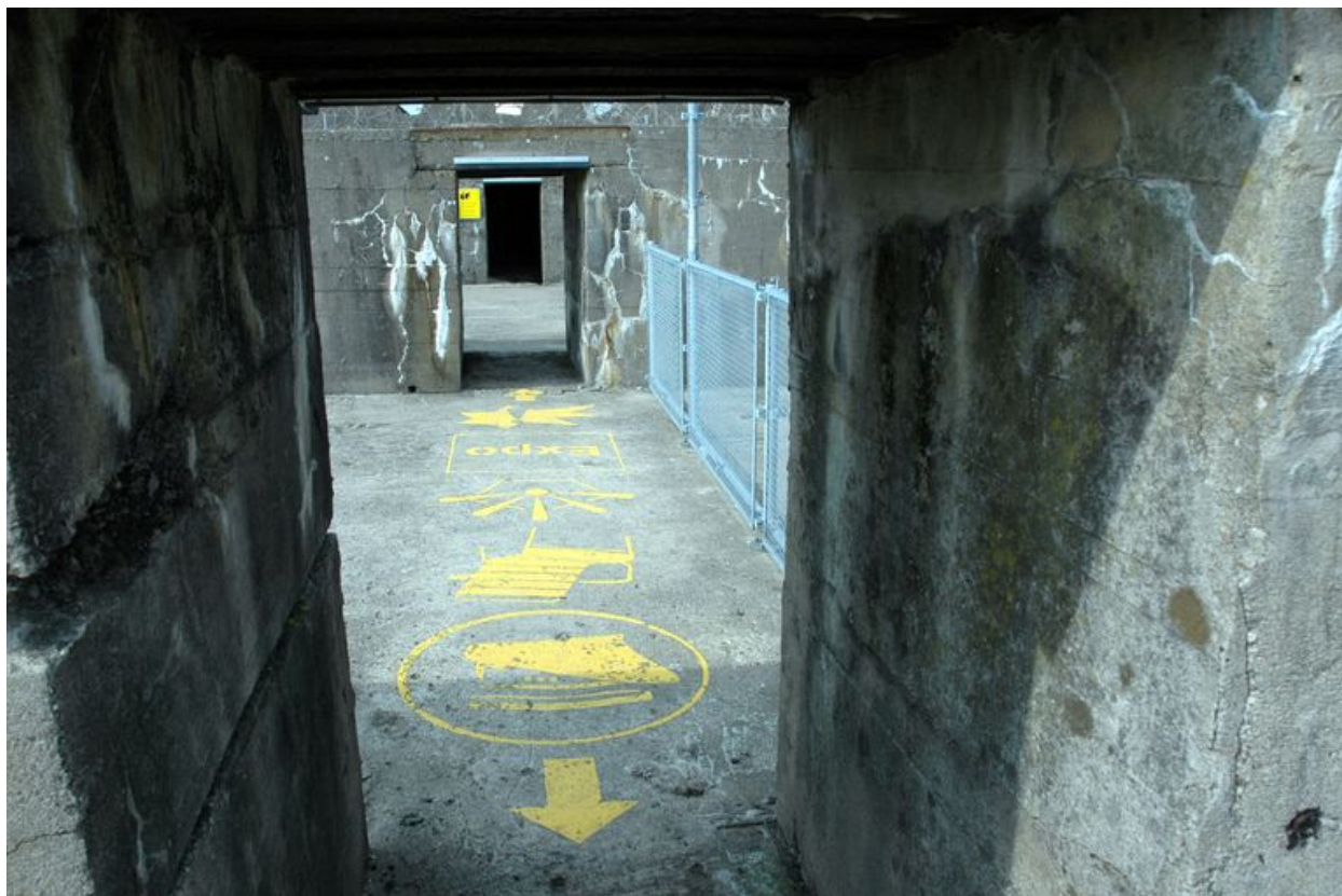
Vue de la chambre d'explosion sous la structure de type Fangrost : une partie de la terrasse est ouverte au public
