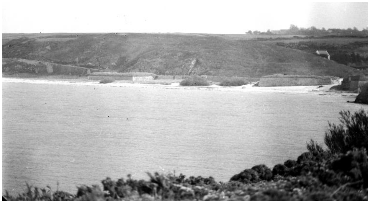
Vue de situation de la porte de Bugull
