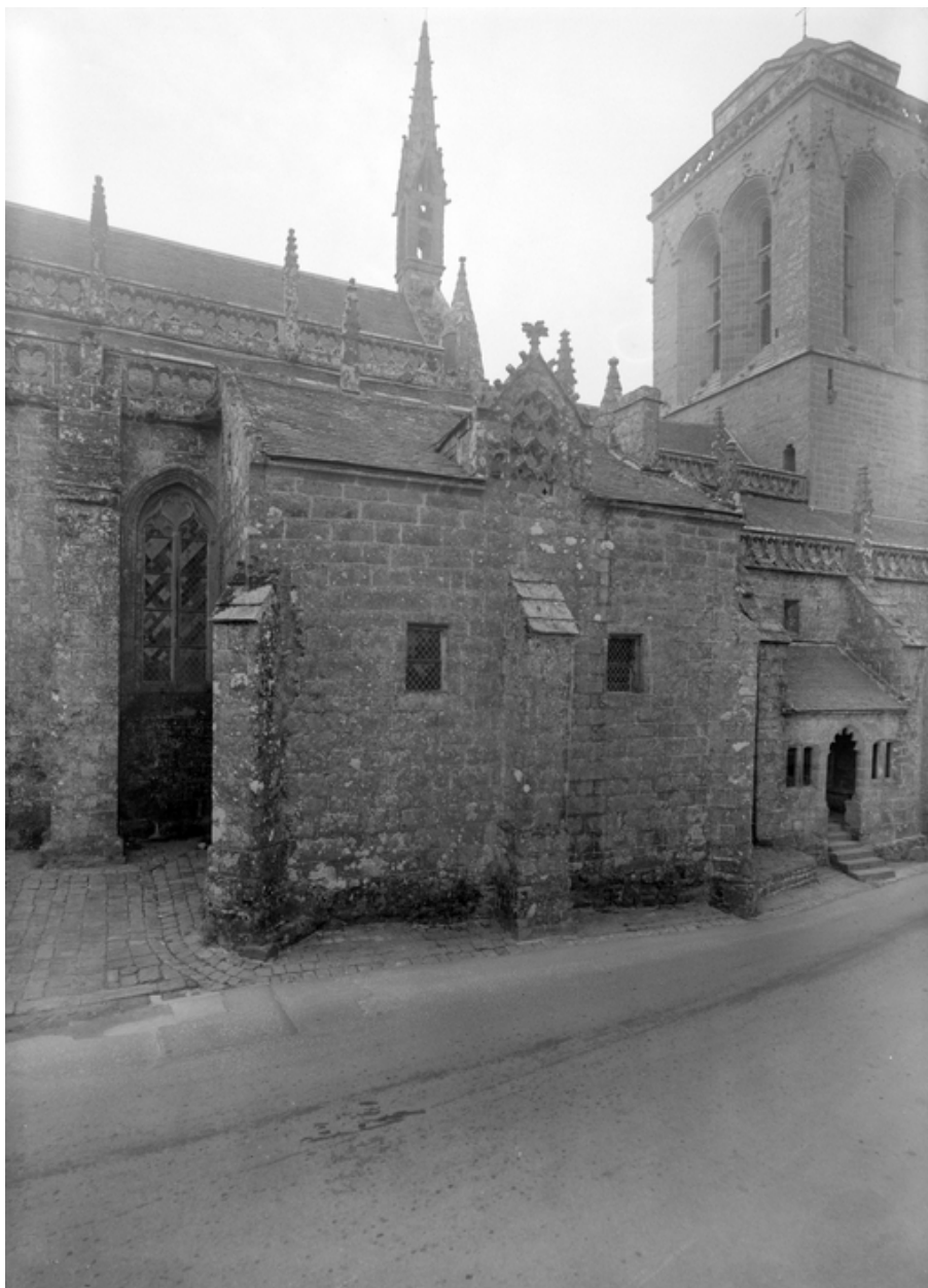
Façade nord, sacristie
