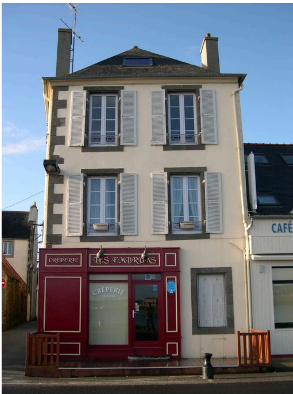
Elévation côté quai de l'ancien magasin de commerce pour l'avitaillement des navires
