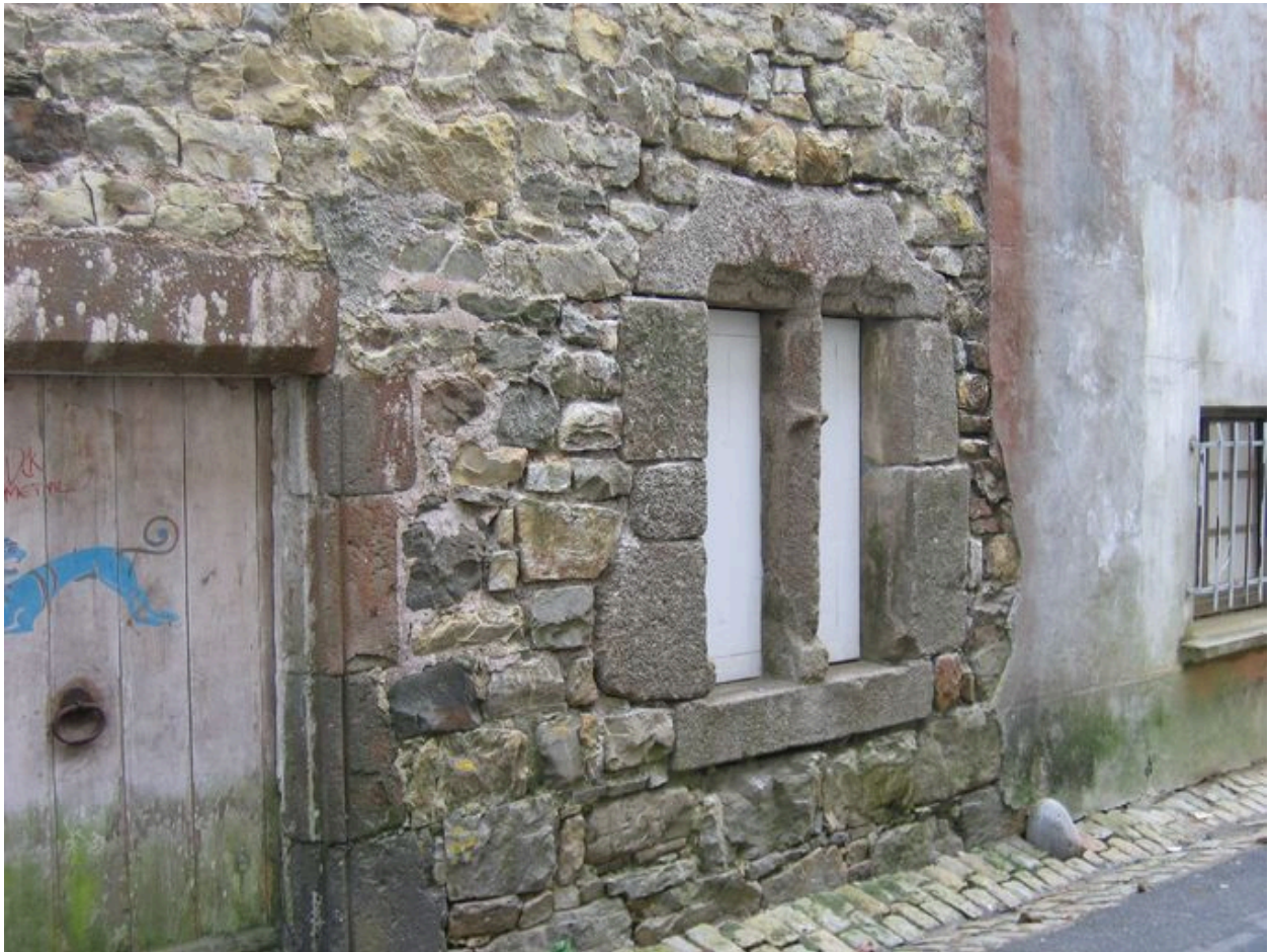
Maison n° 8 (?), détail : baie à meneaux, à 2 accolades
