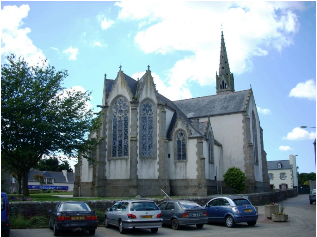
Plouguin, église paroissiale : vue générale nord-est
