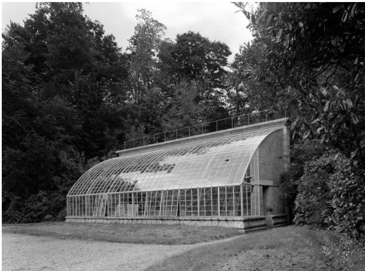
Serre, élévation sud, vue générale
