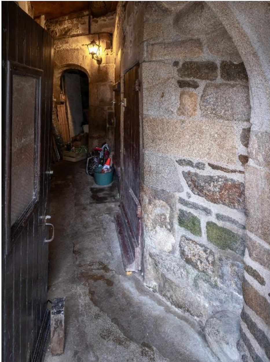
Couloir du rez-de-chaussée séparant l'Hôtel des Uzilles de la maison mitoyenne. Cage d'escalier commune au fond.
